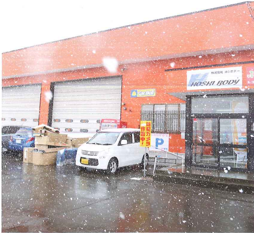
3300㎡の敷地内に3棟の作業棟を構える
