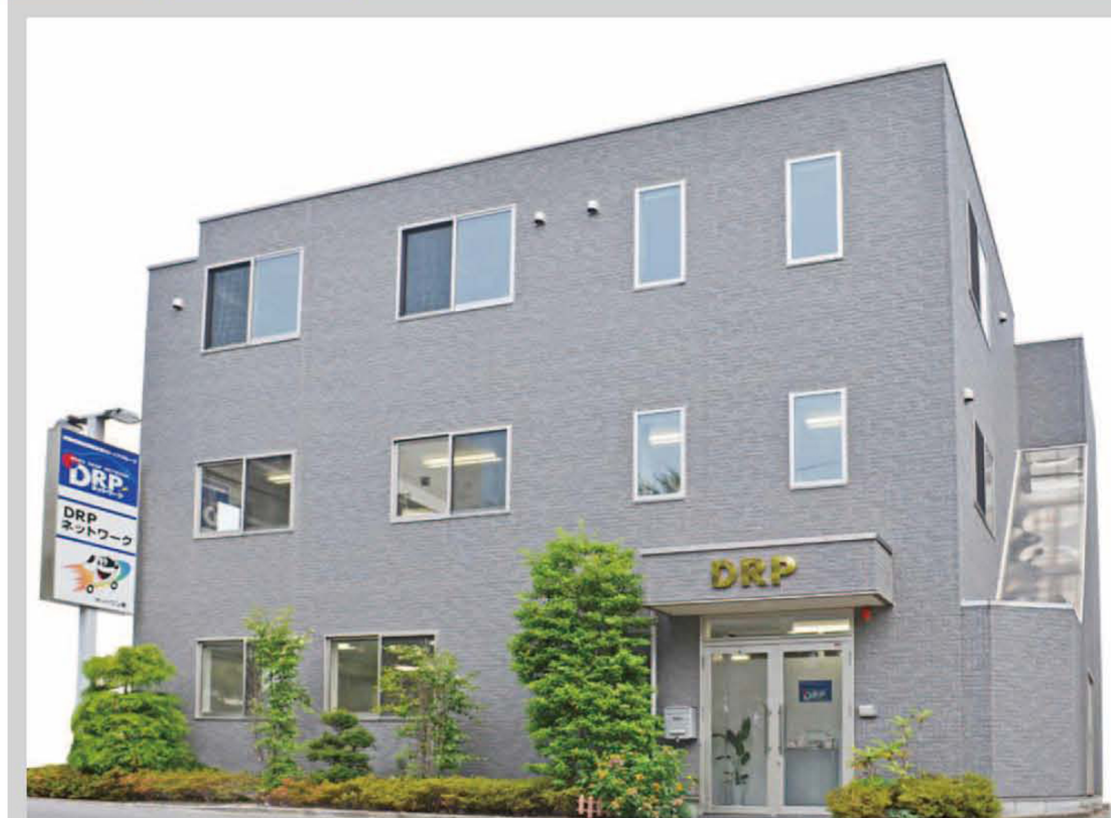
竣工なった新本社屋
